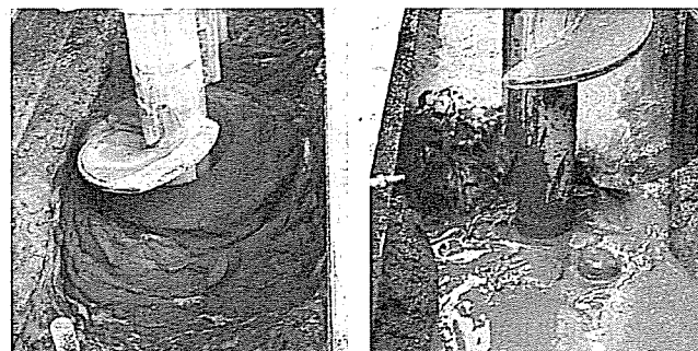
(a)従来工法 (b)ECO-MW工法
