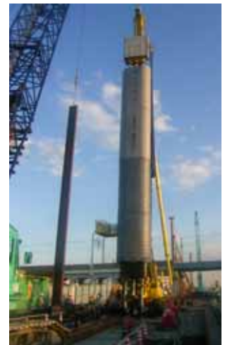
写真 - 5 施工状況
